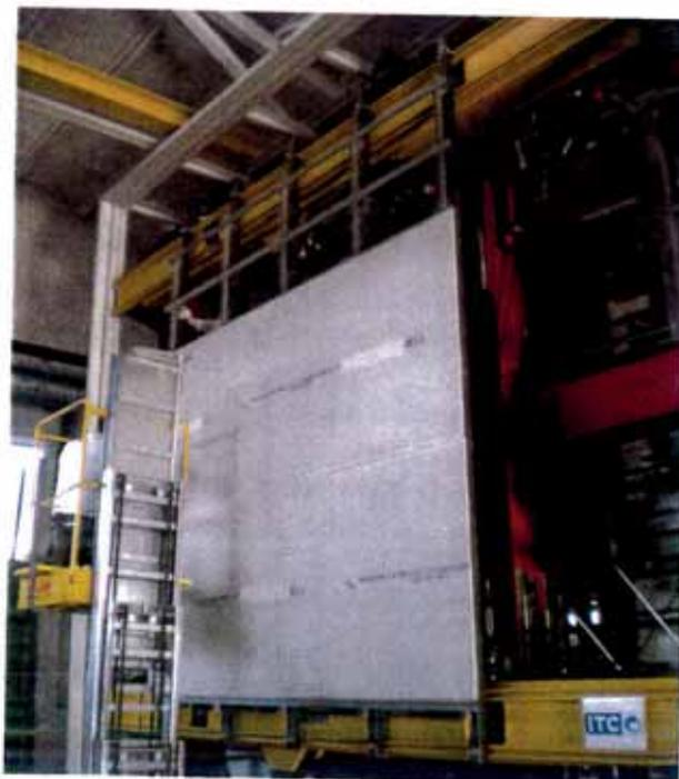
Figura 3: Fase di montaggio dei pannelli alla sottostruttura metallica
