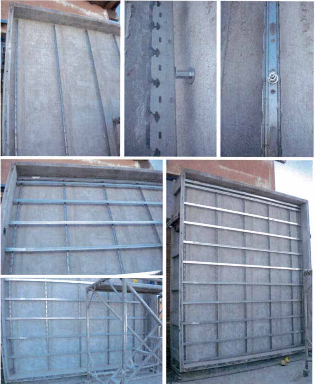
Foto 1, 2, 3, 4, 5 e 6: Fasi principali dell'allestimento del sistema di controparete esterna di isolamento - parte I
