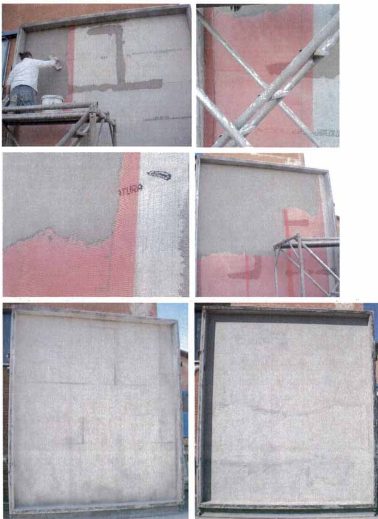
Foto 13, 14, 15, 16, 17 e 18: Fasi principali dell'allestimento del sistema di controparete esterna di isolamento - parte 3
