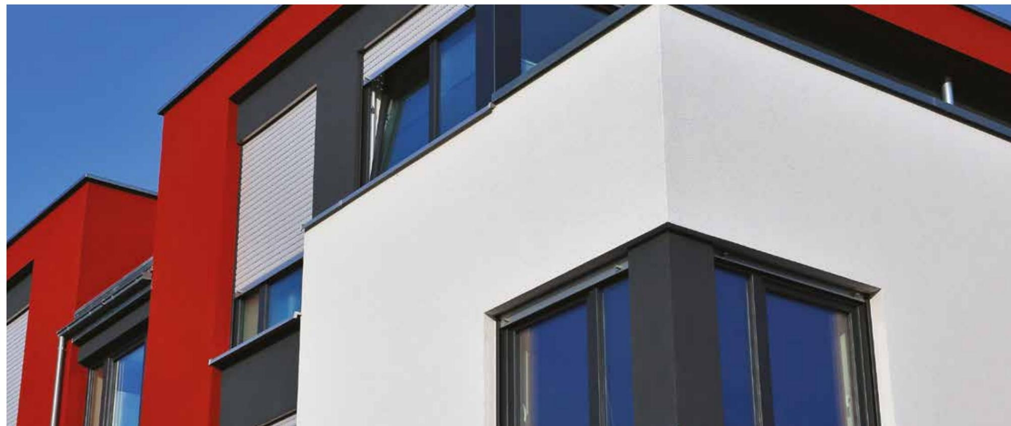
» O sistema é composto por placas de cimento aligeirado fibrado ancoradas sobre uma estrutura de suporte de aço revestido com zinco-magnésio, com interposição de camada simples ou dupla de isolamento termo-reflector e espaçado em caixa de ar simples ou dupla.
